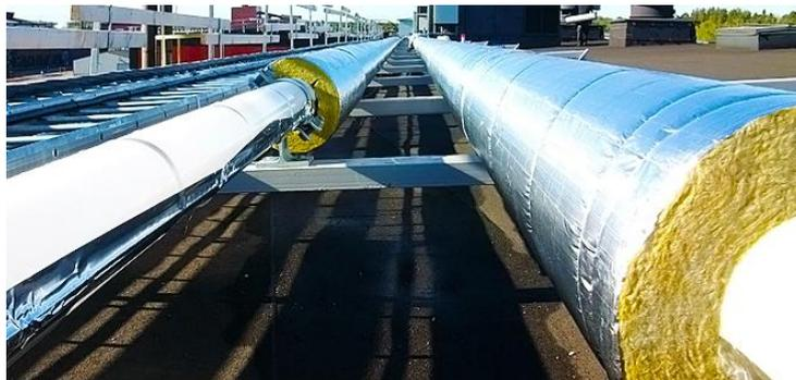
La mayor parte del sistema de tuberías fue instalado al aire libre sobre puentes de tuberías y por lo tanto está permanentemente expuesto a radiación UV y a las condiciones ambientales (de -30 ° C a +40 ° C). Para evitar la congelación o la formación de cristales, el ácido no debe bajar nunca de los +7 °C. Esto puede resultar un desafío, especialmente durante los periodos de inactividad en invierno.
