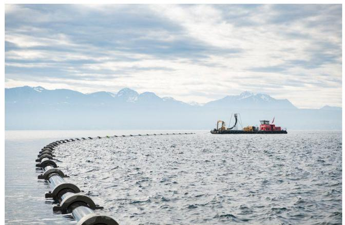
La tubería se inundó cuidadosamente y se bajó hasta una profundidad de 80 m en una nueva curva en forma de S.
