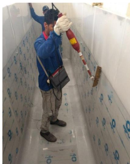
Ejecución de "spark teste" para garantizar 100% estanqueidade
