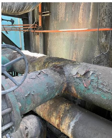
Línea de acero al carbono completamente corroída.
