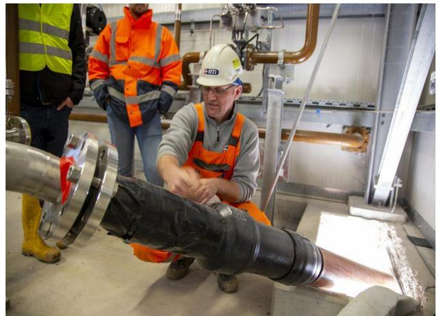
Se instaló un sistema de detección de fugas en el espacio anular de la sala de bombas (exterior).
