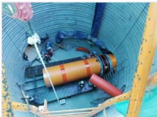
Sistema AGRULINE en PE 100-RC, con aseosría y herramientas de instalación incluidas.
