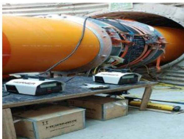
380 metros de tubería de 1600 mm de diámetro y 380 metros de longitud, unidos mediante sistema de acopladores de electrofusión de AGRU.
