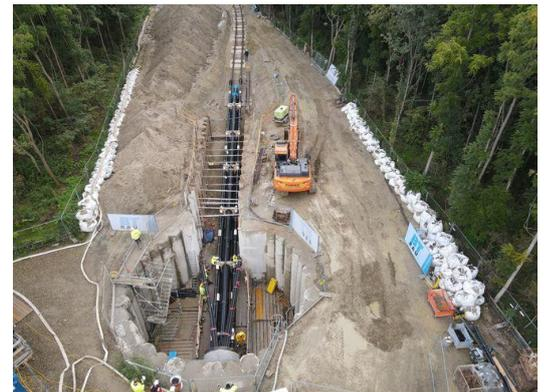
Los tubos pre soldados se introdujeron en la alcantarilla mediante un sistema de rieles.
