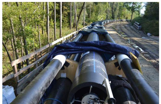
El carro fabricado de acero y madera, permitió introducir las tuberías.
