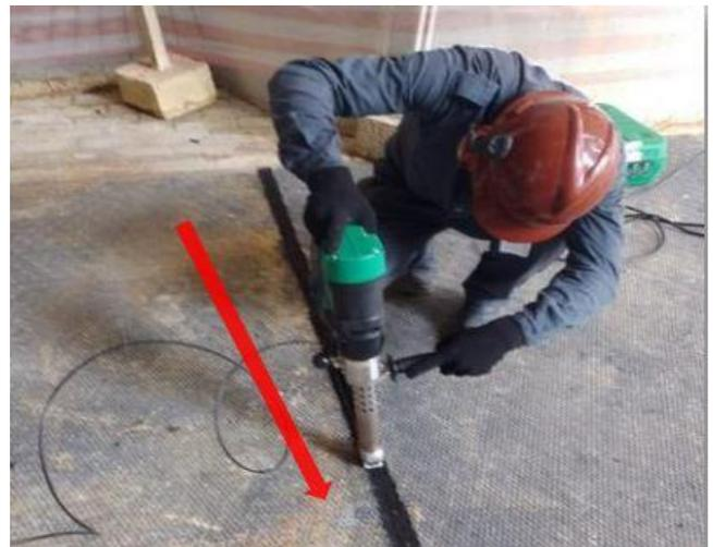
Soldadura por extrusión en el encuentro de placas de revestimiento Sure Grip antiderrapante para protección de pisos.
