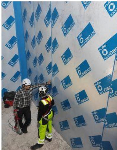
El revestimiento termoplástico sigue sellado con una película protectora.
