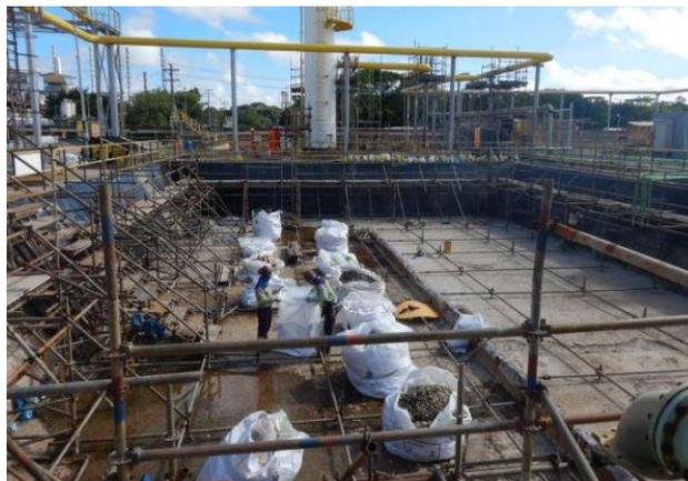
Tal como lo indica el protocolo de instalación, se procede a revestir el piso una vez el proceso de las paredes terminó.
