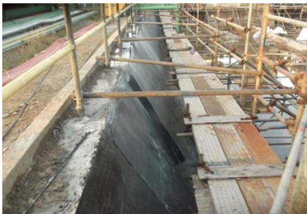
Aplicación de revestimiento Sure Grip PP negro, liso y de 3mm sobre paredes del área de almacenamiento.
