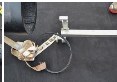
Retirada dos bulbos da soldagem
