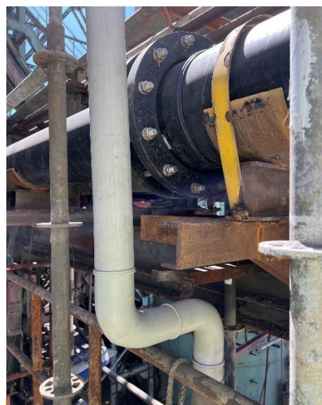
Línea PE 100-RC que reemplaza a línea corroída
