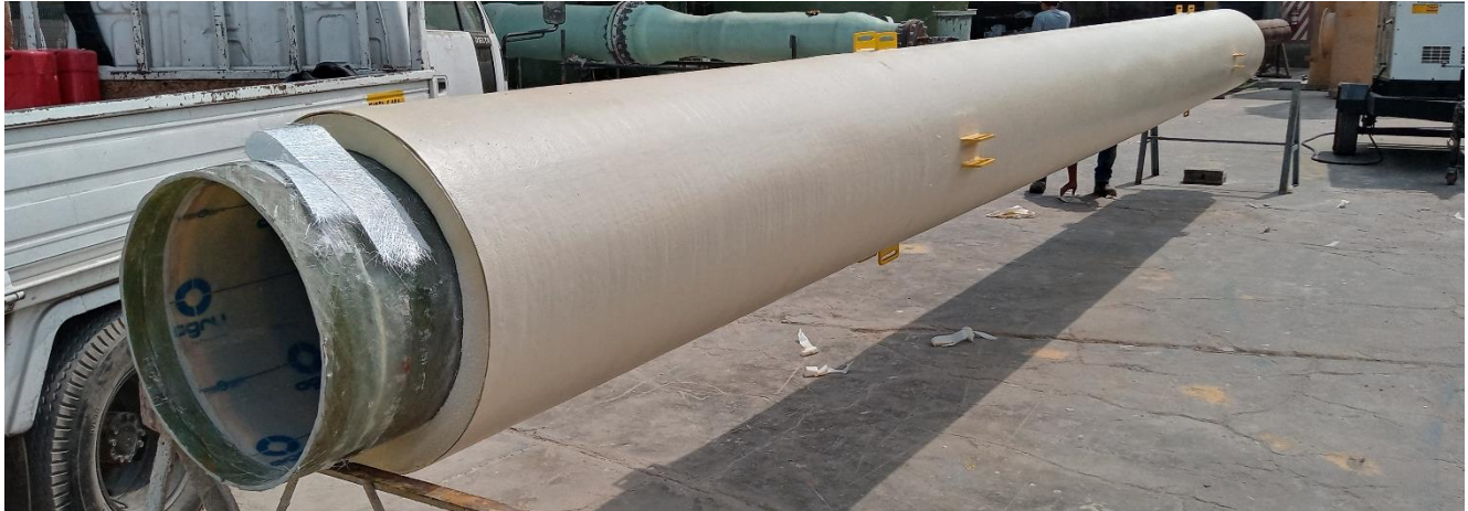
Proceso de laminado de la chimenea con ECTFE SK+
