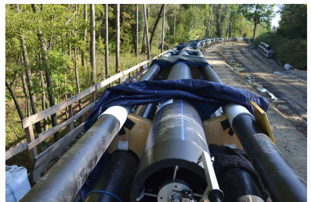
Foram utilizados trilhos de aço e madeira para introduzir os tubos nos túneis.
