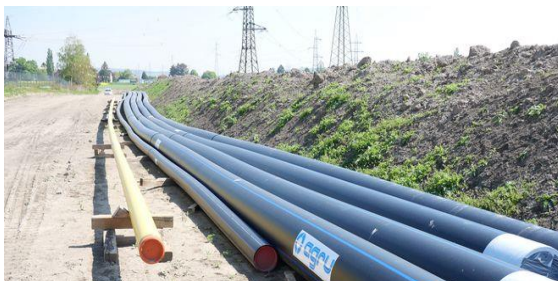
Os tubos AGRULINE PE 100-RC garantem o abastecimento de água potável nas duas margens do Rio Danúbio.
