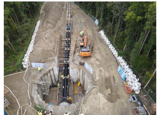
Depois de soldados, os tubos foram introduzidos nos túneis por meio de trilhos.
