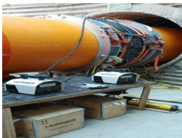
380 metros de tubulação PE 100-RC de 1600 mm com conexões de eletrofusão AGRU.
