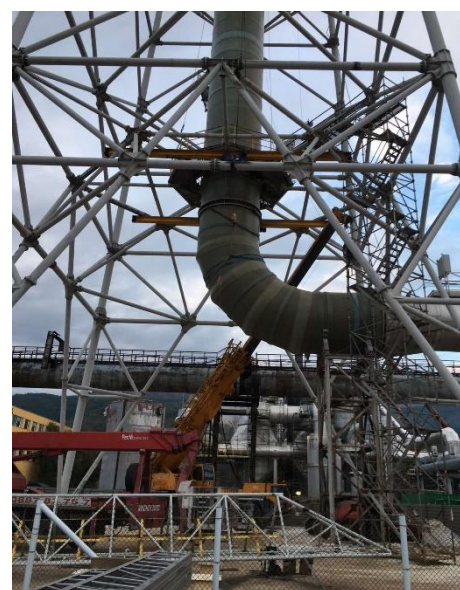
A parte inferior da chaminé
