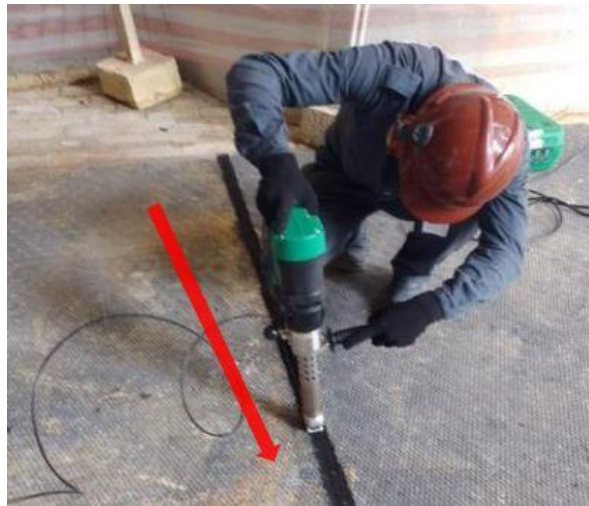
Soldagem por extrusão no encontro entre duas chapas do revestimento Sure Grip antiderrapante para proteção de piso.
